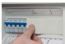
Zaślepka do zakrywania otworów na aparaty
