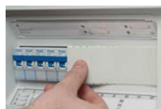
Zaślepka do zakrywania otworów na aparaty
