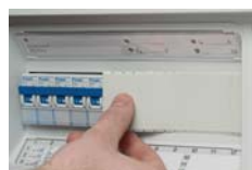
Zaślepka do zakrywania otworów na aparaty
