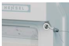
Plombowanie rozdzielnicy
